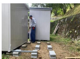
倉庫内機材の運び出し → 基礎ブロック水平取り → 基礎ブロック敷き詰め完成 → 右側倉庫後ろへ移動
