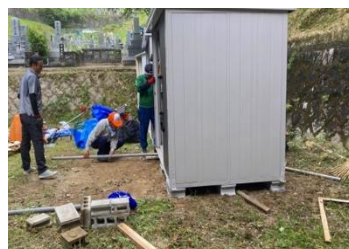
倉庫内機材の運び出し → 基礎ブロック水平取り → 基礎ブロック敷き詰め完成 → 右側倉庫後ろへ移動
