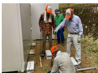
倉庫内機材の運び出し → 基礎ブロック水平取り → 基礎ブロック敷き詰め完成 → 右側倉庫後ろへ移動
