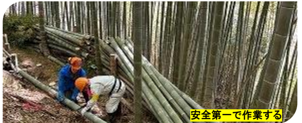
安全第一で作業する
