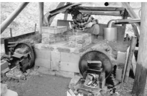
2基の炭焼き窯の間にピザ窯を作りました。溶鉱炉の中古耐火レンガを頂きモルタルで作る本格的ピザ窯の完成！(16.5.9)
