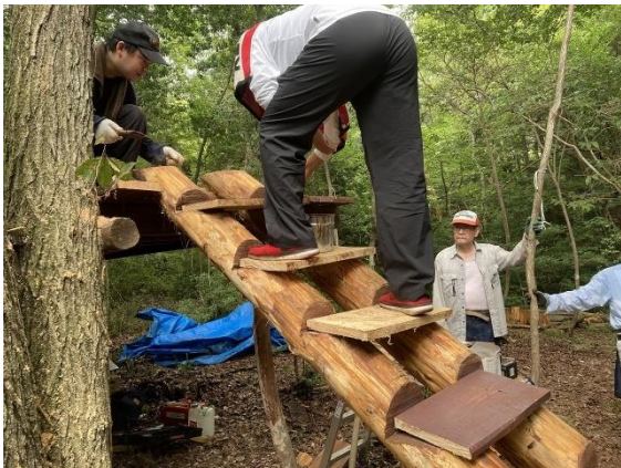
小屋へ上がるための階段づくり
