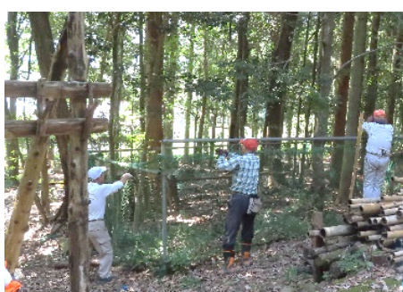
榎木 No2 防護ネット取り付け作業
