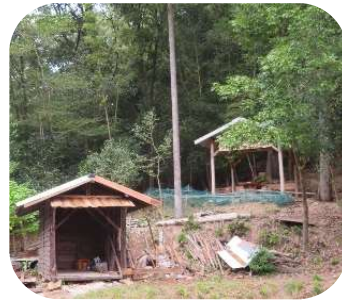
妙國寺納屋整備
