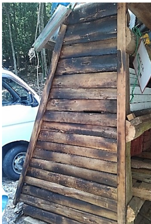
杉板になった倉庫正面の壁
