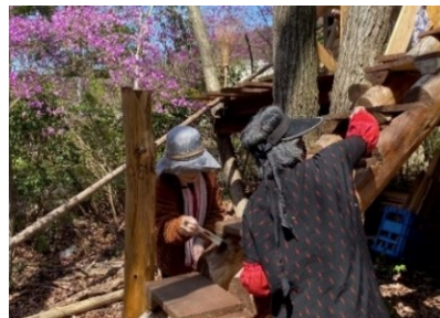
女性も戦力！ツリーハウスの塗装作業
