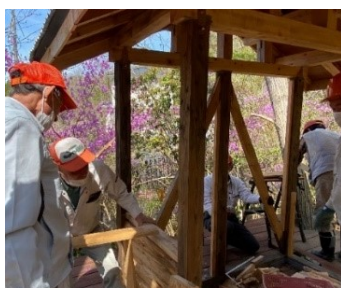
手すり、壁材取付の様子
