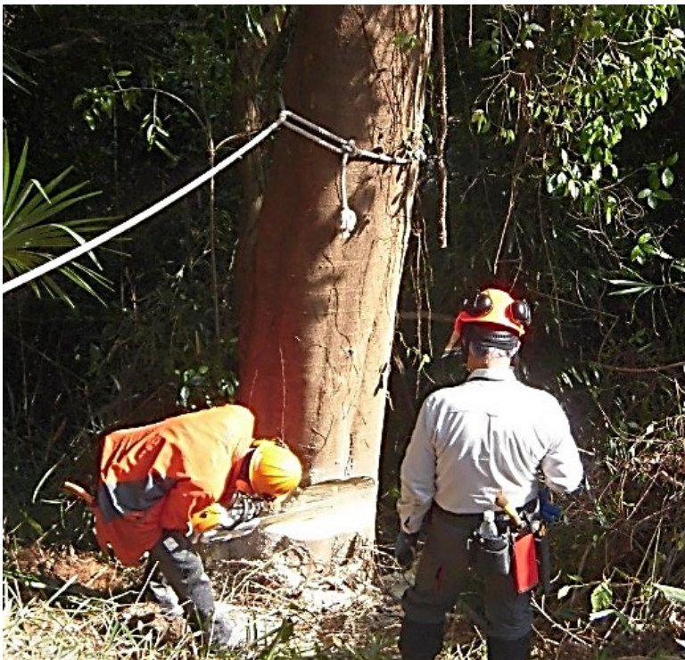
黄金山一の大木 シラカシの伐採(東側法面)。
