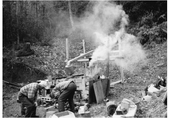
ドラム缶炭焼き窯設置、空焚きを行って不具合が無いか確認中（15. 1. 12）
