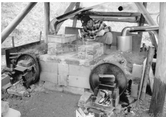
2基の炭焼き窯の間にピザ窯を作る部会員、溶鉱炉の中古耐火レンガを頂きモルタルで作る本格的ピザ窯（16. 5. 9）
