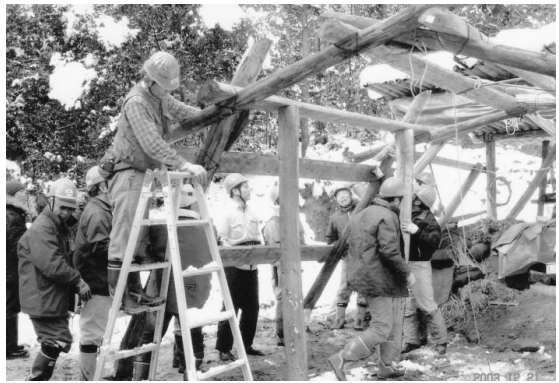
作業小屋の棟上げを行う。前日の20㌢の大雪の後でした。鎌田さん考案の錦帯橋を模した木組みがユニークです。（15. 12. 21）
