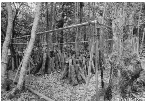
椎茸の圃場の獣害対策ネットを雑木から 単管に更新する (27. 4. 12)
