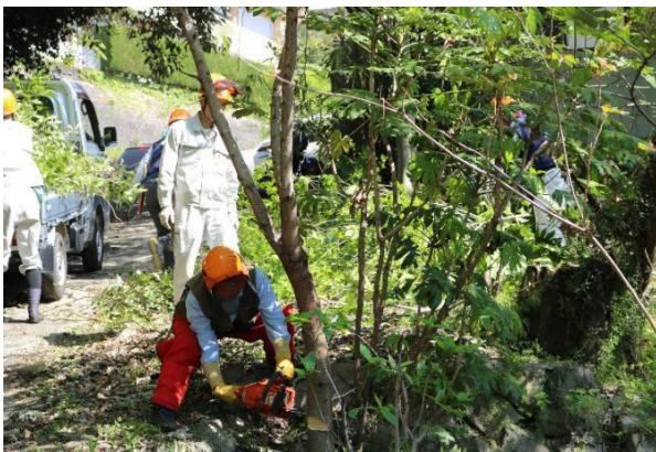
二葉山への参道、支障木の伐採
