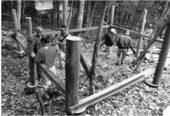
テラス小屋の基礎の上に柱を立てる (22. 12. 12)
